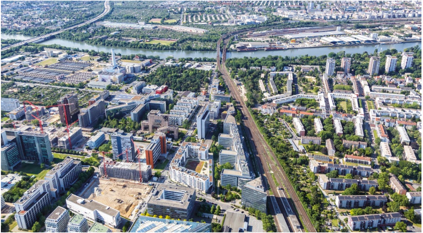
Luftbild der Bürostadt Frankfurt-Niederrad.
