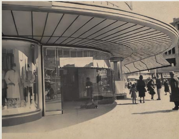
Das eindrucksvolle Gesicht neu gestalteter Schaufensterfronten.
